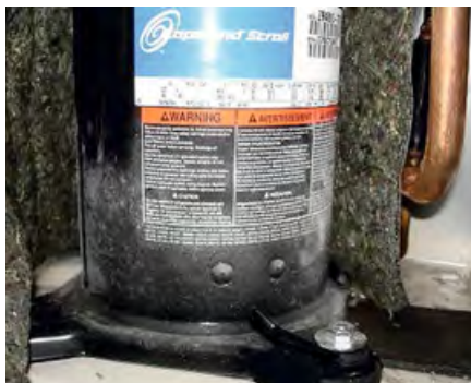
❖ Рис. 5. Недостаточная заправка фреоном привела к обмерзанию компрессора
