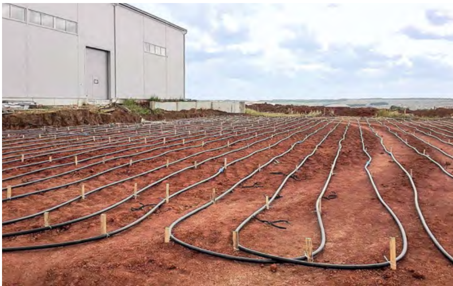
Фото 4. Укладка горизонтального коллектора
