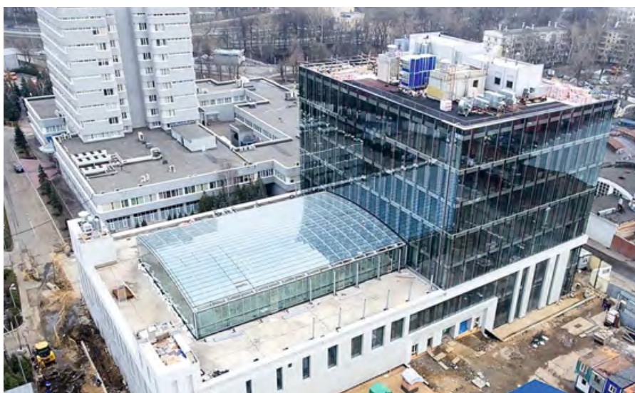
● ● Крышная котельная De Dietrich
