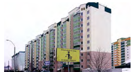
Рис. 8. Энергоэффективное здание, построенное в городе Могилёве
