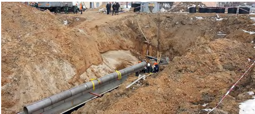
Рис. 5. Выполнение работ на стадии строительства
