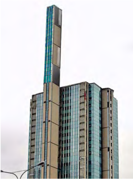
❖ Фото 4. Проект энергетической стелы на высотном здании на ул. Вернадского в Москве
