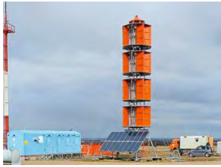
•• Фото 16. Ветроэнергетический комплекс «Буран» на основе вертикально-осевой установки турбинного типа с направляющим аппаратом
