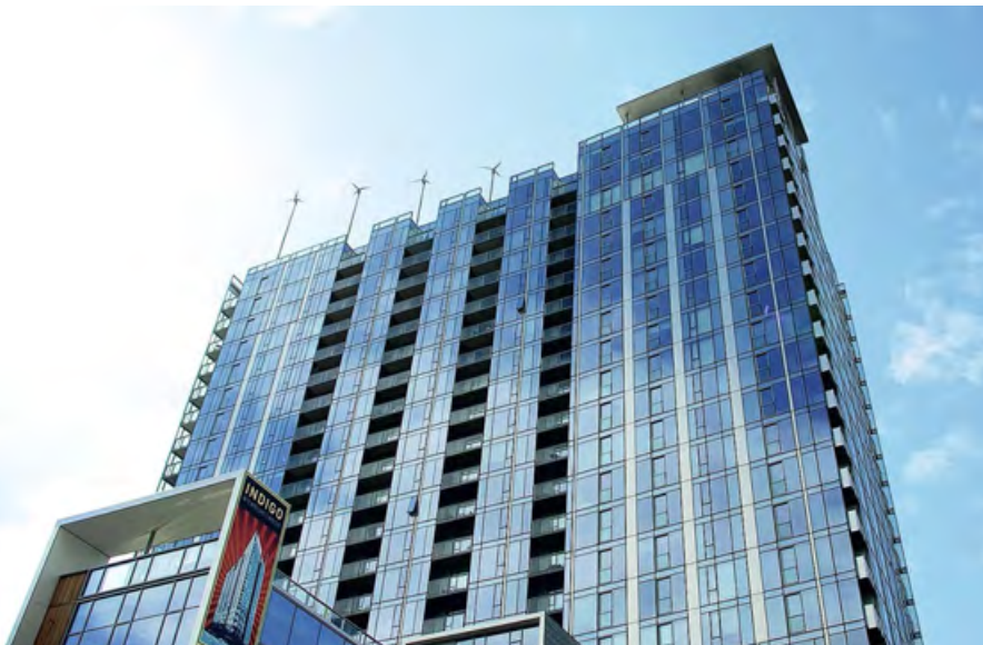
❖ Фото 1. Здание на Twelve West Street в городе Портленд (штат Орегон, США)
