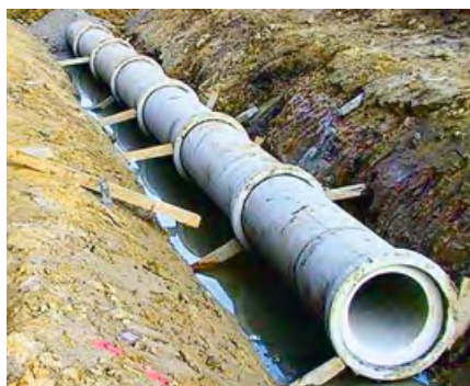
∴ Рис. 2. Фрагменты укладки подземных водоотводящих трубопроводов из безнапорных труб (слева — бетонных, справа — полимерных со структурированной стенкой)
