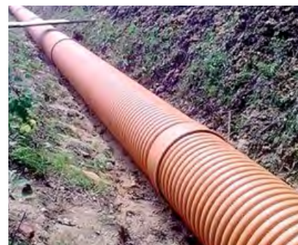
∴ Рис. 2. Фрагменты укладки подземных водоотводящих трубопроводов из безнапорных труб (слева — бетонных, справа — полимерных со структурированной стенкой)
