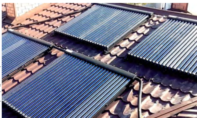
● ● Фото 23. Гелиосистема, установленная на частном доме в городе Анапа Краснодарского края
