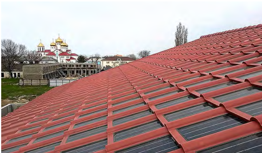
❖ Фото 3. «Солнечный дом» в городе Анапа Краснодарского края жилой площадью 150 м 2 с крышей из «солнечной черепицы» мощностью 2 кВт
