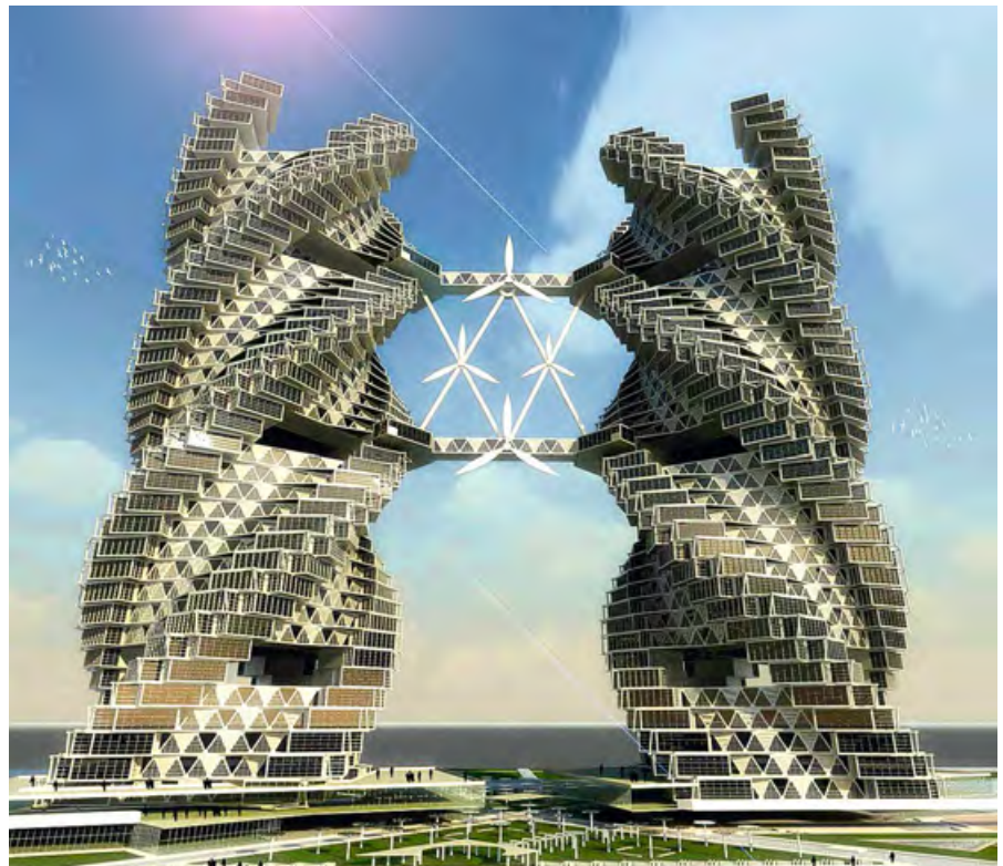
❖ Фото 3. Проект небоскрёба в Индии с традиционными пропеллерными ВЭС. Каким бы массивным здание не было, при некоторых скоростях вибрация и ультразвук от пропеллерных ветряков будут ощутимы. А во время ураганных ветров турбины надо стопорить, но вибрация останется
