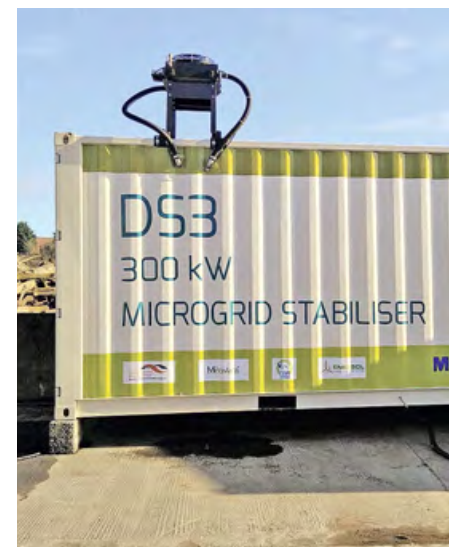
Система FREQCON's DS3 Microgrid Stabiliser на основе суперконденсаторов для нужд ВИЭ
