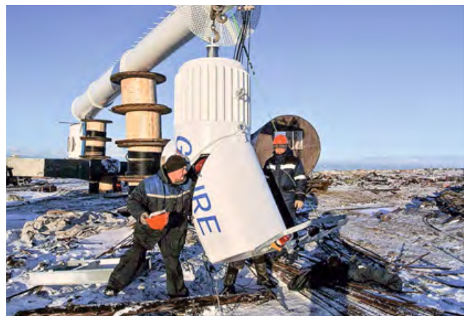
Фото 10. Бескрановый монтаж ВЗУ в посёлке Амдерма
