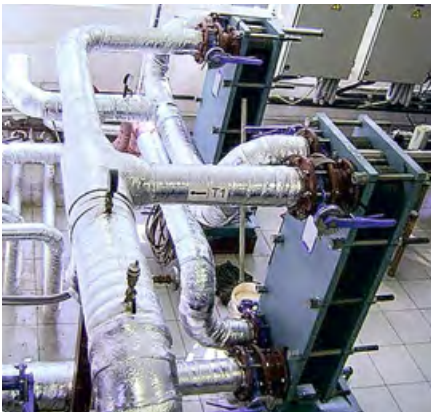
Системы съёма низкопотенциального тепла от грунтовой воды
