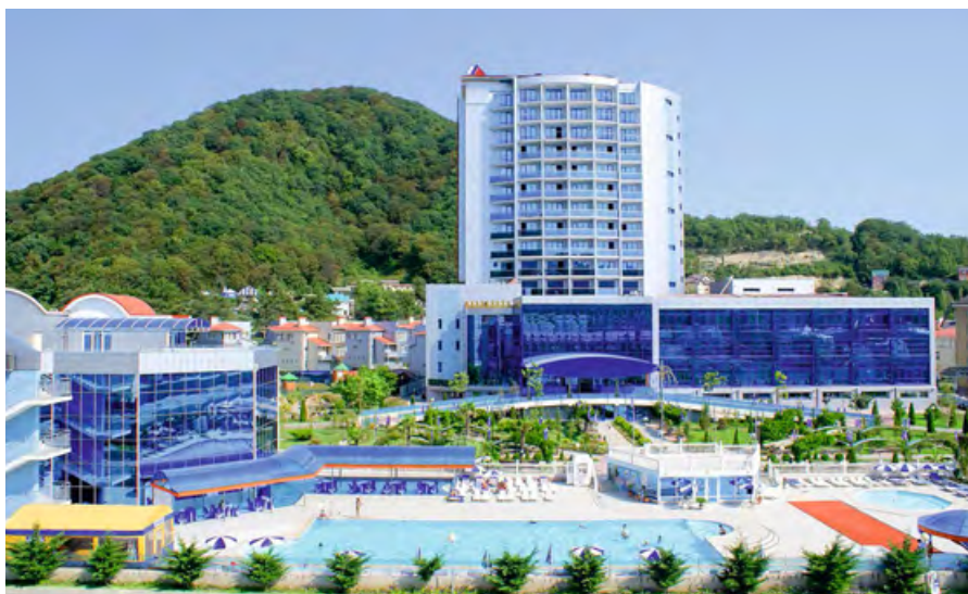
❖ Гостиничный комплекс 4**** «Гамма», оборудованный ТНУ мощностью 1 МВт
