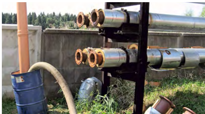
•• Фото 8. Промывка теплообменника-утилизатора
