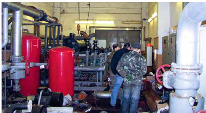
•• Фото 4. Монтажные работы по реконструкции оборудования АТНУ
