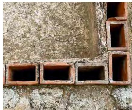
⌘ Системы обогрева *hypocaust* (слева) и вертикальные каналы *tubuli* для дымовых газов
