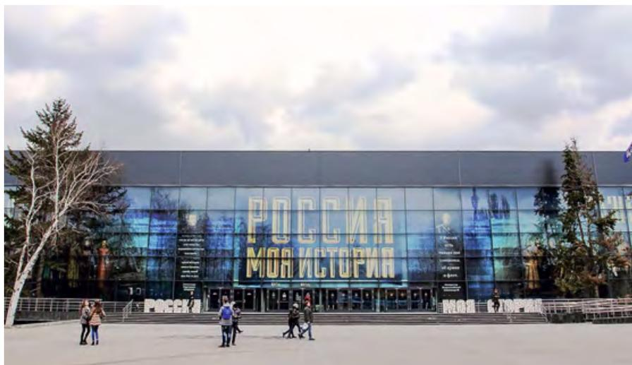
Павильон отличает большая площадь фасадного остекления, что создаёт повышенную нагрузку на системы кондиционирования за счёт избыточного поступления солнечного света и дополнительного прогрева, что требует увеличения мощности оборудования.
