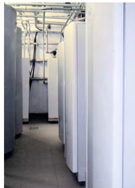
❖ Каскад тепловых насосов на одном из объектов компании ООО «Экоклимат» в России
