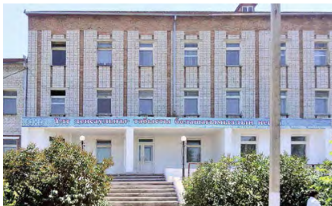
❖ Районная больница Курчумского района ВКО, оборудованная тепловыми насосами
