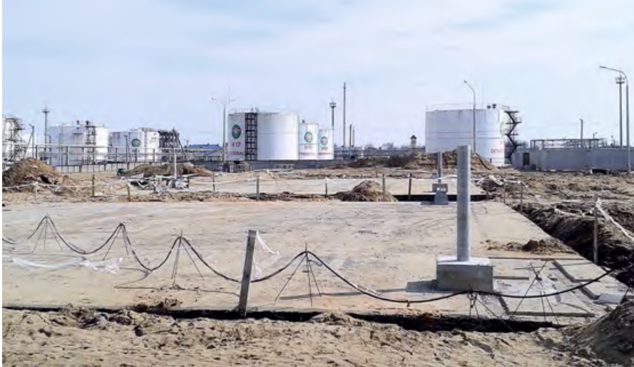
❖ Система резервуаров для аккумуляции и очистки дождевой воды
