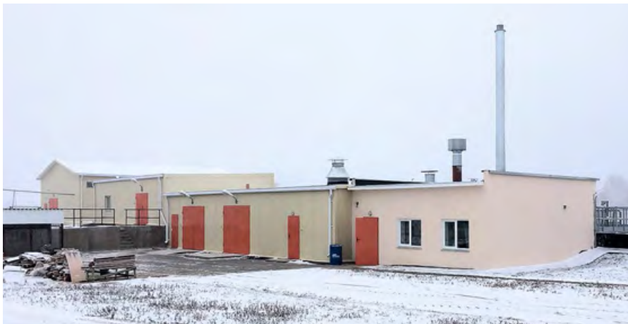
❖ Здание очистных сооружений города Особино
