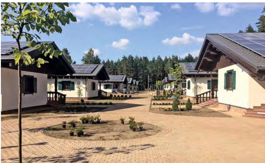
❖ База отдыха «Красный Бор» — установлено 1020 кВт геотермальных тепловых насосов и фотогальванических установок мощностью 260 кВт. В текущем году в связи с расширением комплекса запланировано дополнительно поставить отдельный тепловой пункт мощностью 120 кВт
