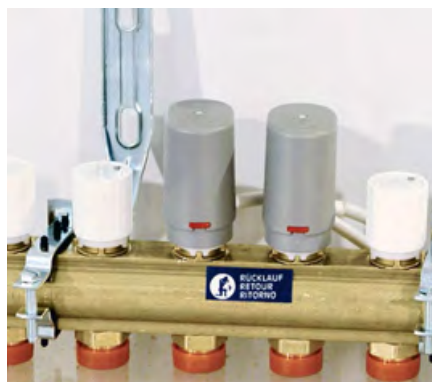
❖❖ Установка приводов на обратном коллекторе
