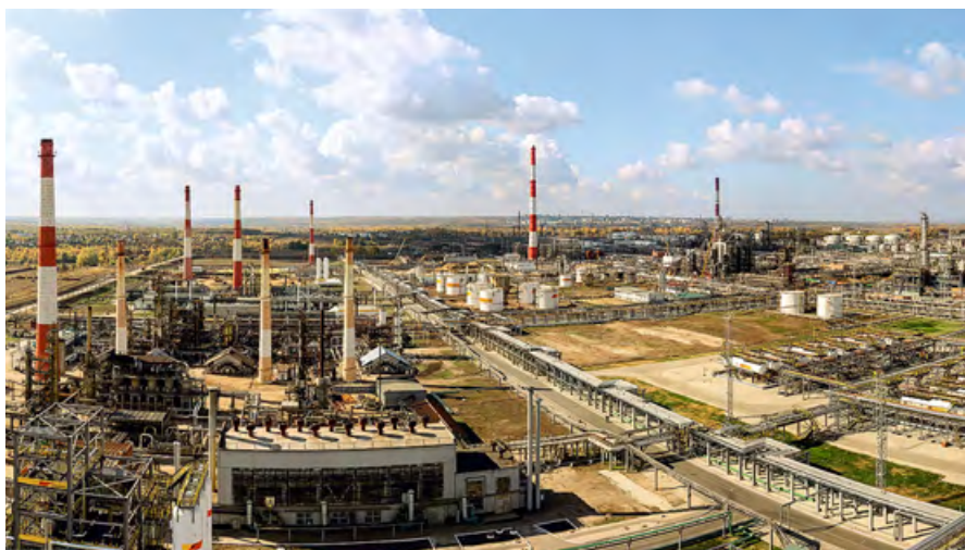
•• Куйбышевский нефтеперерабатывающий завод
