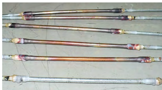
❖ Фото 3. Пайка трубок холодильника
