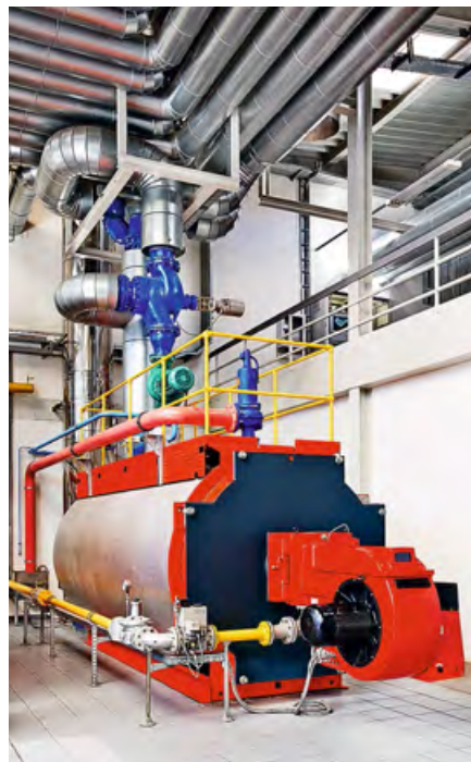
❖ Промышленный водогрейный котел Bosch Unimat UT-L российского производства
