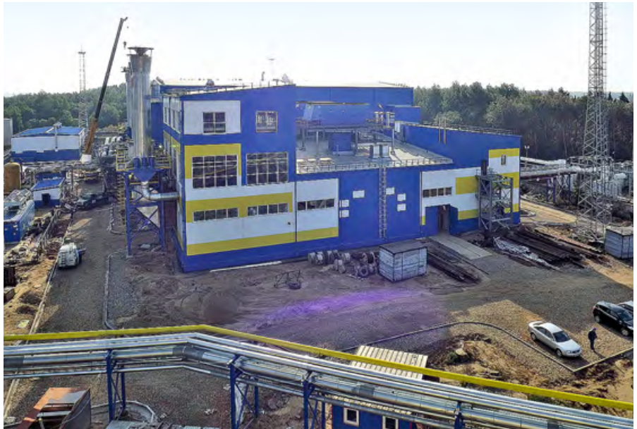
Строящаяся Тутаевская парогазовая установка (ПГУ)
