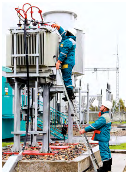
❖ Ремонтные работы на подстанции «Чайка»
