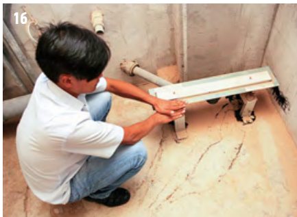
⚡ Фото 1. Установка канала TECEdrainline на переходе из мокрой в сухую зону с декоративной решеткой quadratum
