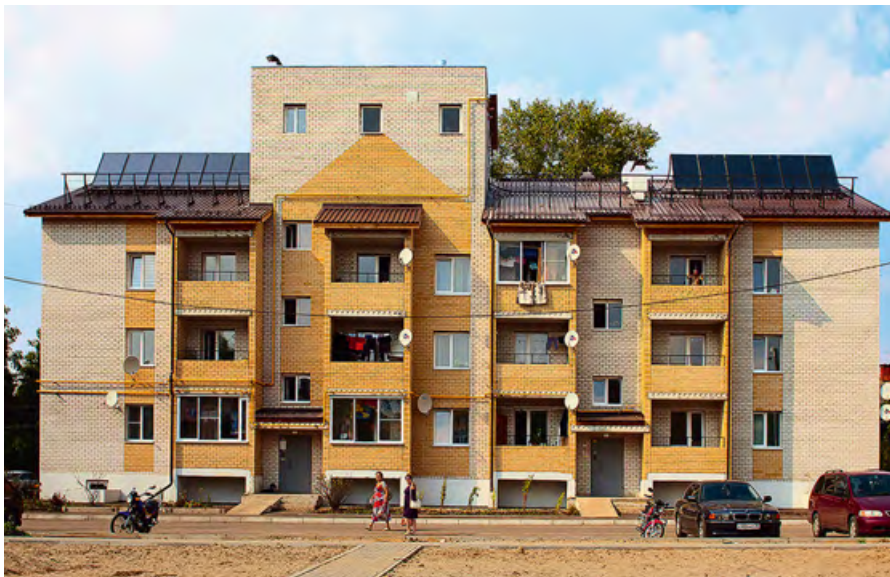
❖ Энергоэффективный дом в Собинке (Владимирская область) — 12 коллекторов Buderus Logasol SKS 4.0s и два котла Logamax plus GB112
