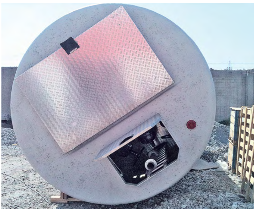
⚡ Комплектная канализационная насосная станция в процессе установки
