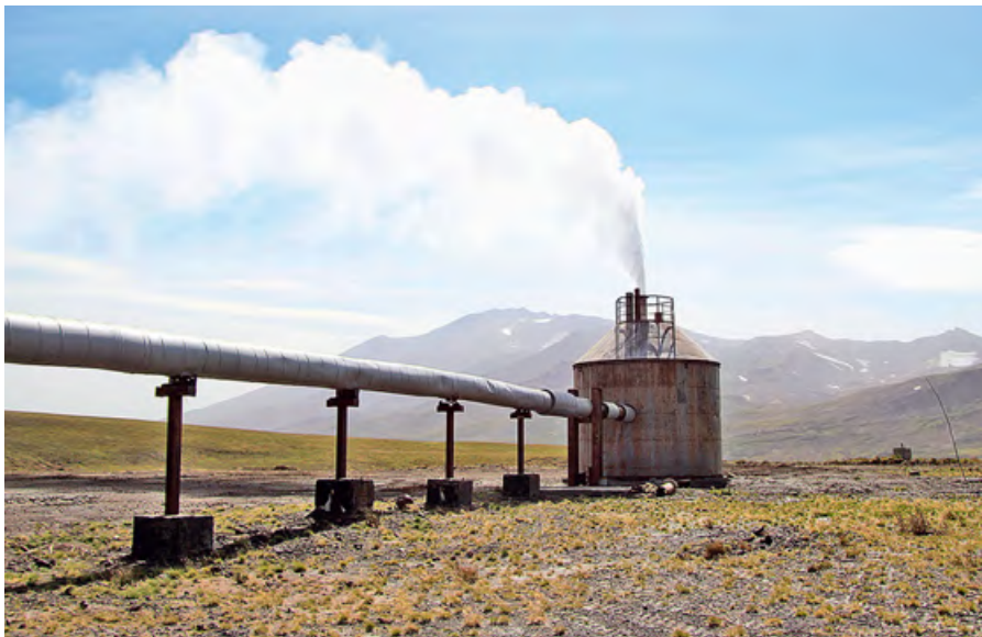
❖ Скважина на Мутновском геотермальном месторождении, Камчатка
