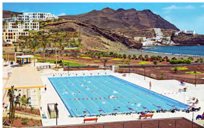
Фото 1. Гелиоустановка с пластиковыми СК бассейна отеля Playitas в испанском городе Fuerteventura
