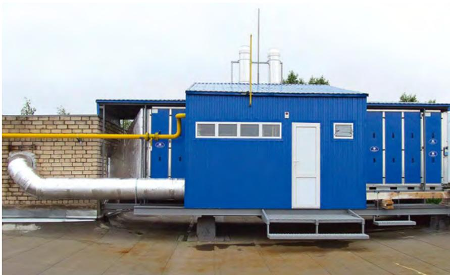
❖ Фото 3. Приточная установка со встроенными газовыми секциями нагрева
