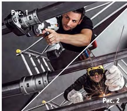
⚡ Соединение стальных трубопроводов с помощью пресс-системы Viega Megapress выполняется без труда и лишь в несколько операций (рис. 1). В то время как сварка труб, например, в труднодоступных местах или в сложных конструкциях крайне затруднена (рис. 2)
