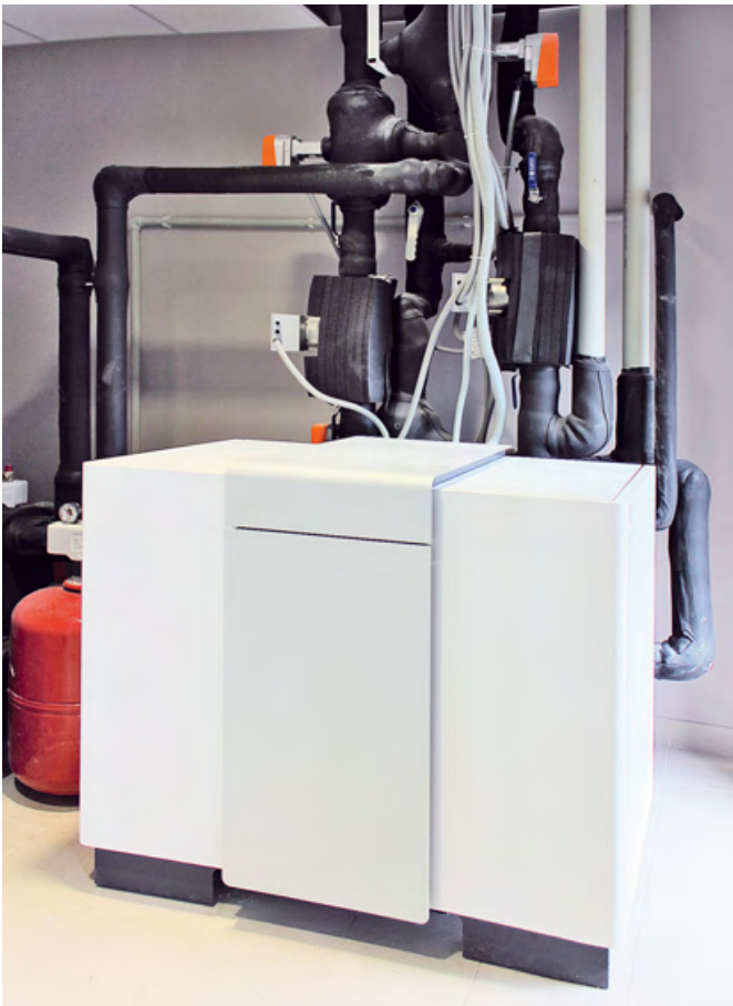
❖ Фото 10. Finalный этап монтажа теплового насоса WPF 66G
