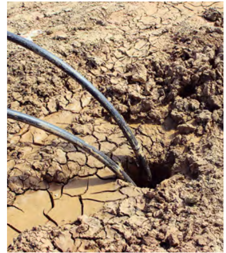
Фото 3. Скважина с опущенным геотермальным зондом Upronog
