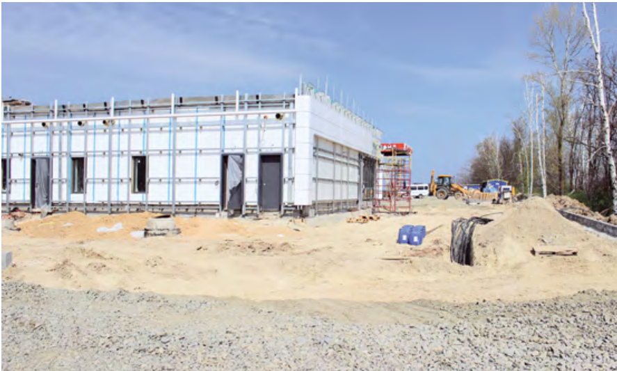
Фото 2. Участки геотермальных зондов, сводимых в колодец
