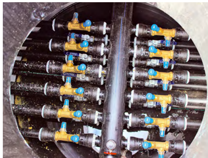
❖ Фото 6. Распределительная гребенка с балансировочными вентилями высокой пропускной способности в геотермальном колодце
