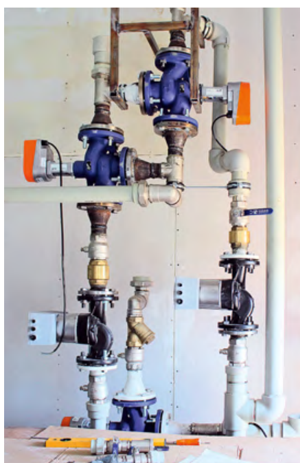
❖ Фото 7. Монтаж геотермального теплового насоса
