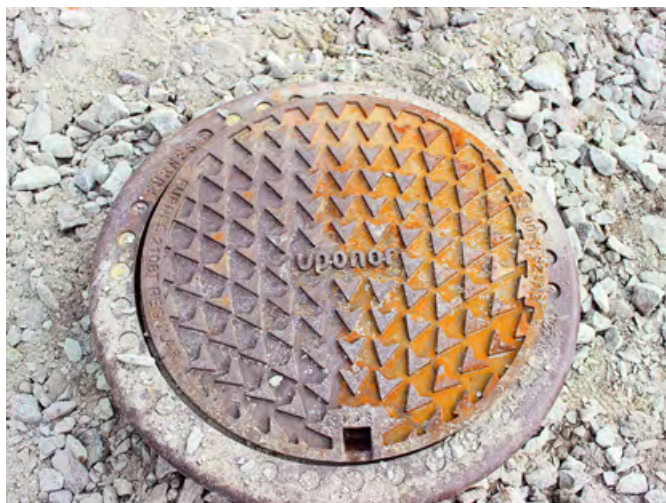
❖ Фото 5. Крышка смонтированного геотермального колодца Урого
