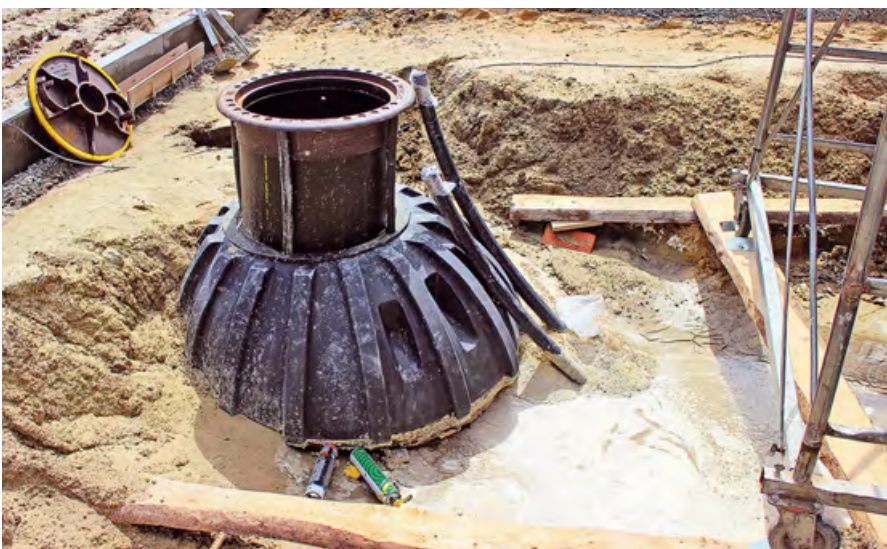
Фото 4. Установленный в котловане геотермальный колодец Upronog
