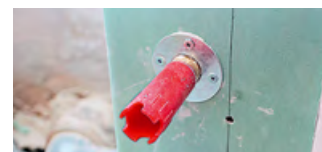
⌘ Угловые фитинги для сквозной установки в гипсокартонную перегородку
