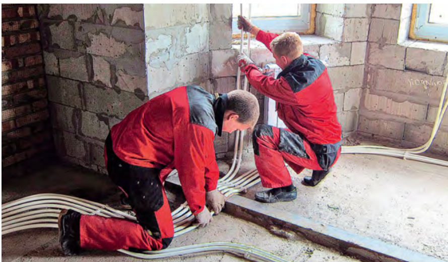
При подобном монтаже как раз и может возникнуть «воздушная пробка» (рис. 1)
