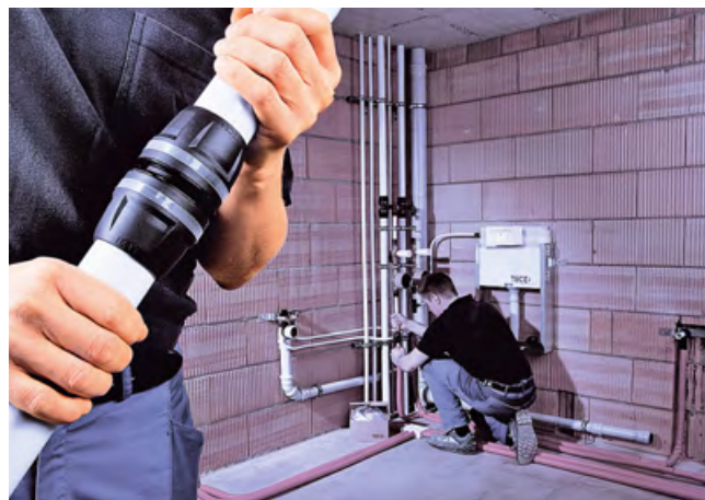
:: Система TECElogo применяется для труб диаметром от 16 до 63 мм. Можно сделать не только герметичную разводку по квартире, но и по всему дому, в том числе стояки водоснабжения
