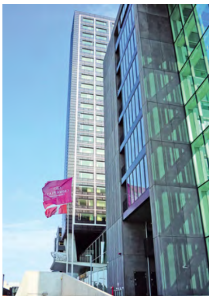
⌘ Самый «зеленый» отель Европы — Crowne Plaza Copenhagen Towers, оснащенный энергоэффективным оборудованием Grundfos
