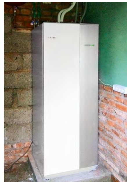
❖ Фото 2. Наружный (слева) и внутренний блоки ТН. Применен при модернизации котельной на баллоне сжиженном газе. В прошлую зиму потреблено 200 баллонов, в эту — ноль (дом — 280 м 2 , семья — шесть человек, осуществляется отопление и приготовление горячей воды)
