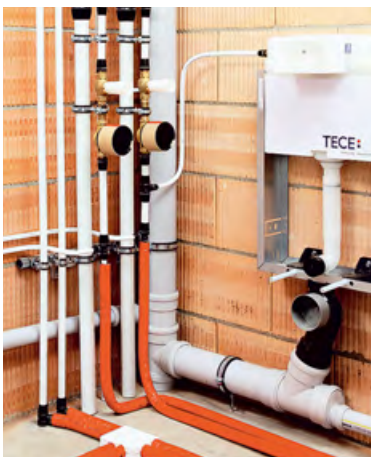
:: Система TECElogo применяется для труб диаметром от 16 до 63 мм. Можно сделать не только герметичную разводку по квартире, но и по всему дому, в том числе стояки водоснабжения
