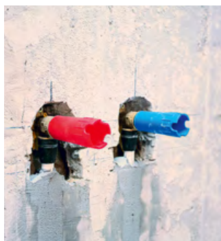
⌘ Герметичность соединения дает возможность замуровывать фитинги в стену
