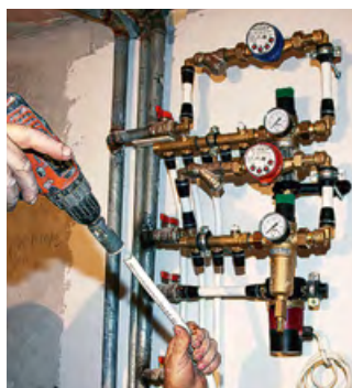
⌘ При помощи насадки и обычного шуруповерта калибруется труба и снимается фаска
