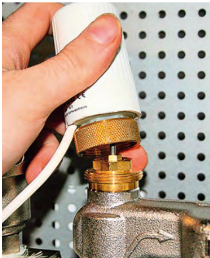
Рис. 6. Снятие привода терморегулятора
