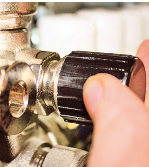
Рис. 7. Установка максимального перепада на перепускном клапане
