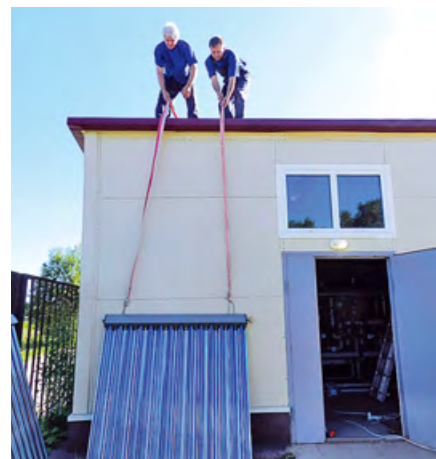
❖ Подъем коллекторов на крышу ИТП
