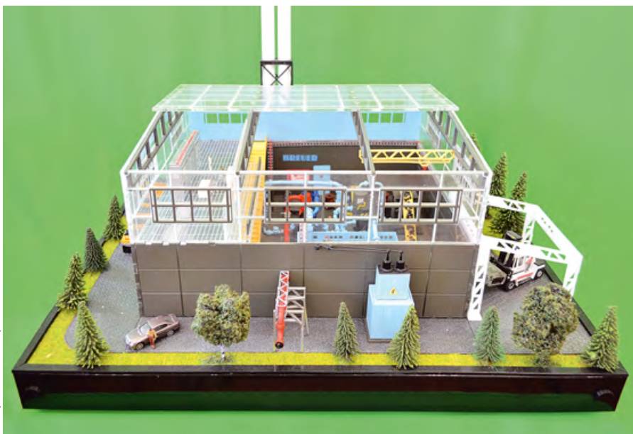
❖ Макет мини-ТЭС (1,2 МВт) на твердом топливе с производством побочного продукта
