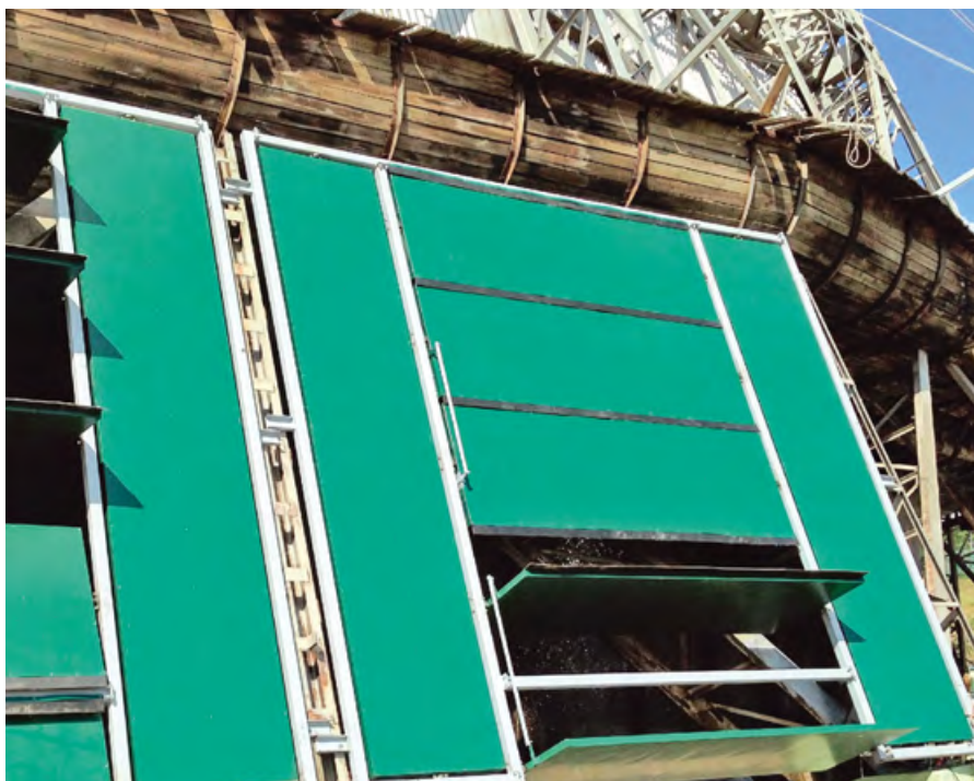
❖ Фото 2. Предлагаемая система воздухоуравновешивания
