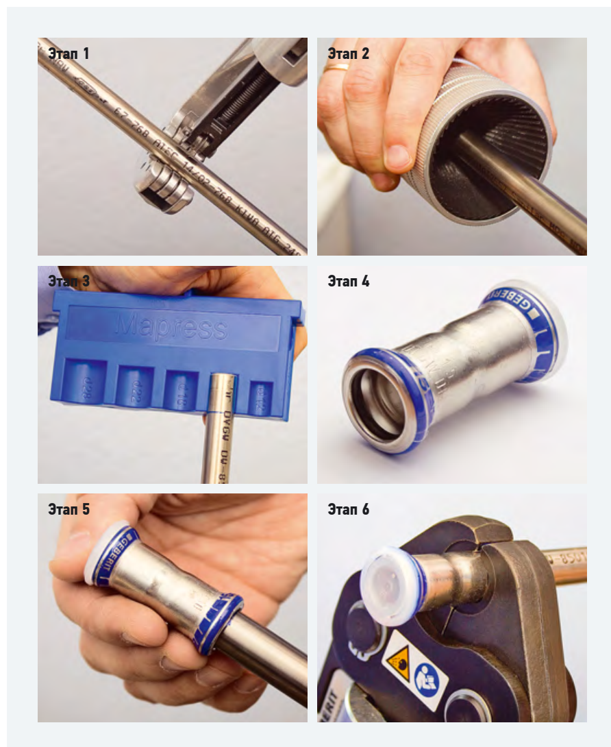
⚙️ Фото 1. Шесть этапов процесса создания пресс-соединения Geberit Mapress
