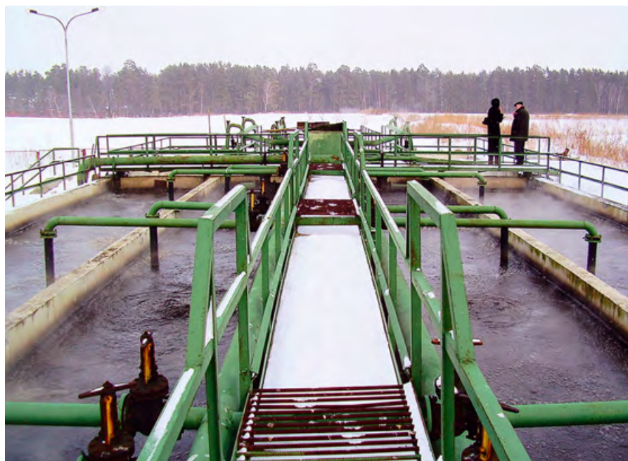
❖ Фото 3. Очистные сооружения «Реабилитационного центра ЦБ России» после реконструкции
