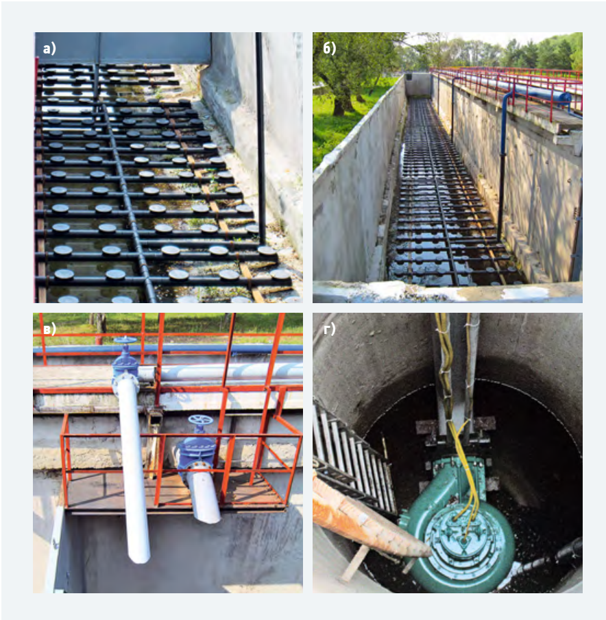
❖ Фото 4. Аэротенк и иловая насосная станция после выполнения строительно-монтажных работ реконструкции и модернизации [а — зона (аноксидная) денитрификации; б — зона нитрификации; в — подача сточной воды и рециркуляционного активного ила в зоны денитрификации; г — иловая насосная станция]
