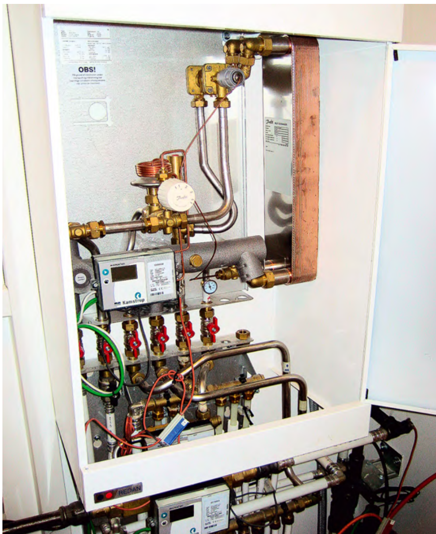
❖ Фото 3. Домовой ИТП с быстрым водонагревателем и тремя теплосчетчиками (счетчик состоит из вычислителя и ультразвукового расходомера, сверху на фото теплосчетчик для учета тепла, полученного от теплосети, в середине счетчик энергии ГВС и внизу счетчик, регистрирующий теплопотребление ветки, на которой установлено 11 ИТП данного типа)
