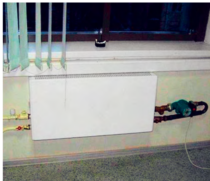
Рис. 9. Пример «форсированной» обвязки конвектора
