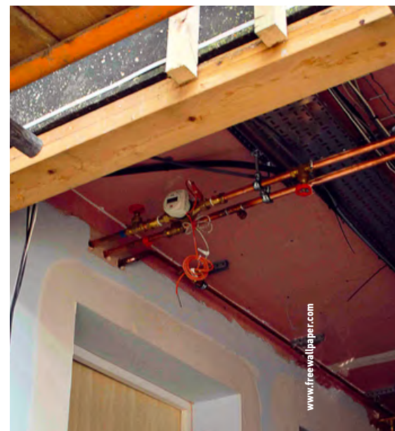
❖❖ Рис. 1. Система отопления с отбором горячей воды (измерительные компоненты каналов измерительной системы — термометры и расходомеры)
