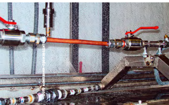
❖ Фото 2. Испытание концевок для медных труб
