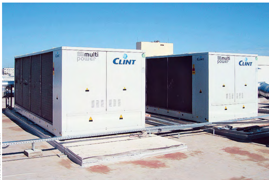
⊞ Чиллеры Clint на крыше торгового центра «Реал» (г. Ростов-на-Дону)
