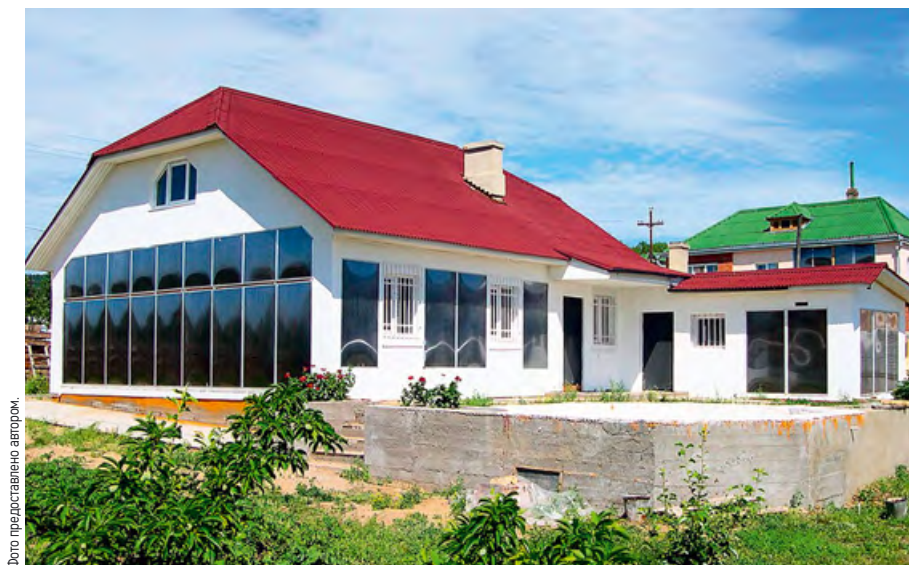
●● Фото 3. Гелиоустановка жилого дома в г. Улан-Удэ с пластиковыми СК
