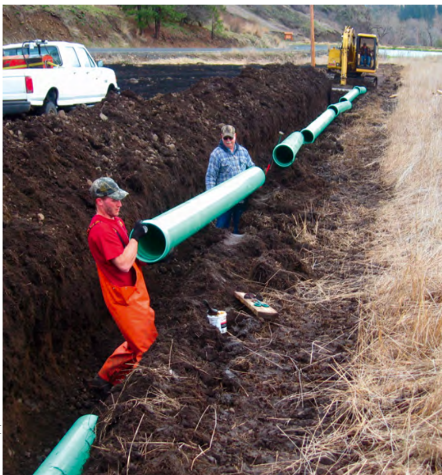
■ Ручная прокладка канализационных труб как эталон низкзатратных работ
