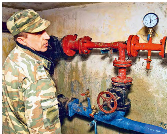
⚡ Фото 10. Контроль опрессовки
