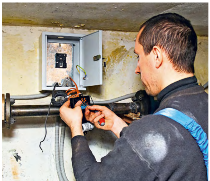
❖ Фото 8. Установка вычислителя
