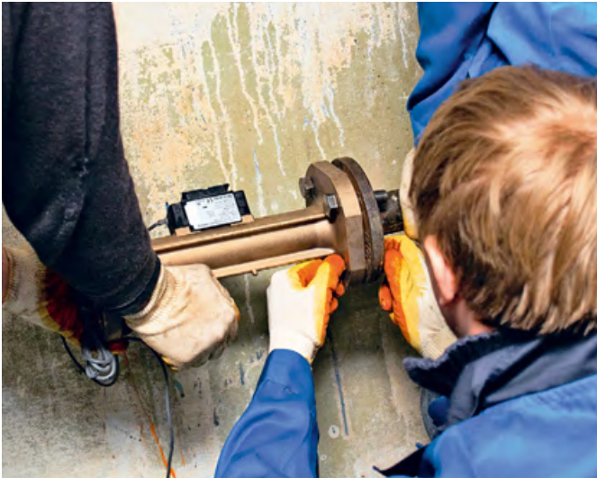
❖ Фото 5. Сборка узла учета на объекте
