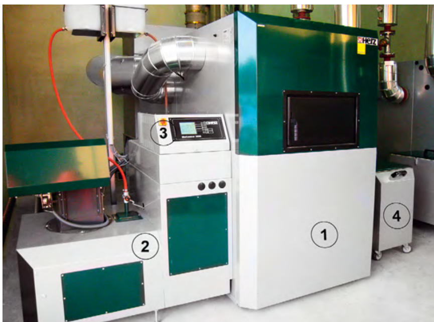
Рис. 4. Каскадное подключение двух установок BioMatic 500 и BioControl 3000
