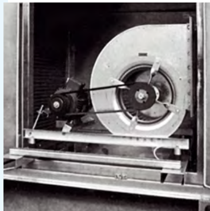
■ Рис. 15. Вентиляционная секция центрального кондиционера
