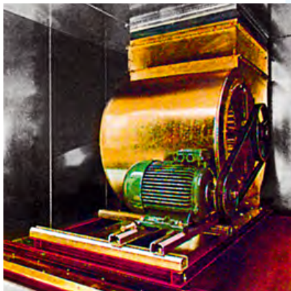
■ Рис. 15. Вентиляционная секция центрального кондиционера
