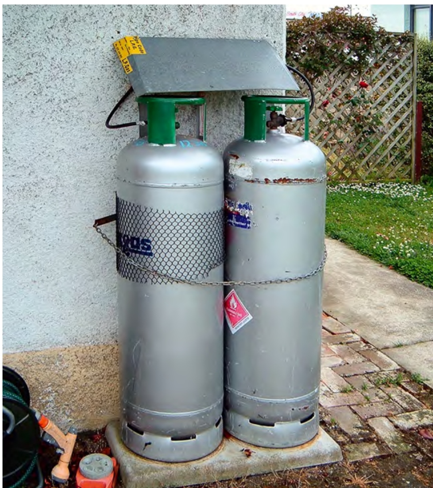
Рис. 1. Надежность снабжения потребителей сжиженным газом при наружной установке баллонов (1 — марка сжиженного газа ПТ — пропан технический по [2]; 2 — марка сжиженного газа СПБТ — смесь пропан-бутана техническая по [2])
