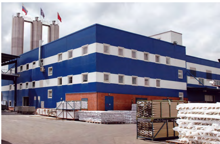
■ Холодильные машины с естественным охлаждением на заводе «Терна Полимер» (Московская обл.)
