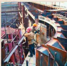
Строительство Ростовской АЭС
