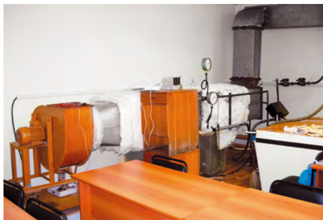
■ Фото 1. Общий вид аэродинамической установки
