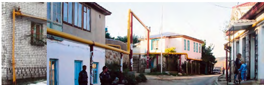
■ Домовой ввод газопровода и магистральный газопровод, проложенный по главной улице поселка Малый Маяк в Крыму
