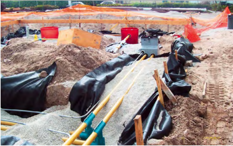
Восстановление подземного трубопровода компанией Florida Metro Construction Company, Inc. (США)
