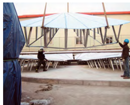
■ Опорный каркас, донные панели — резервуар 300 м 3
