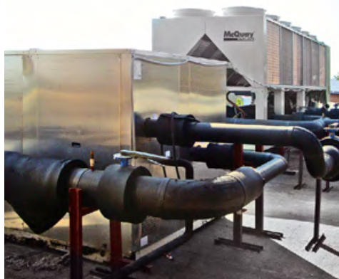
■ Чиллер с гидромодулем на переднем плане
