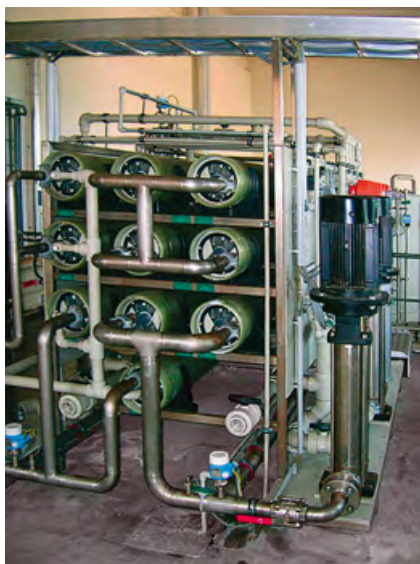
Рис. 2. Система обратного осмоса для умягчения воды на ТЭЦ в г. Штаер
