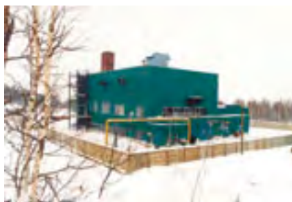
Газотурбинная теплоэлектростанция «Шигили»
