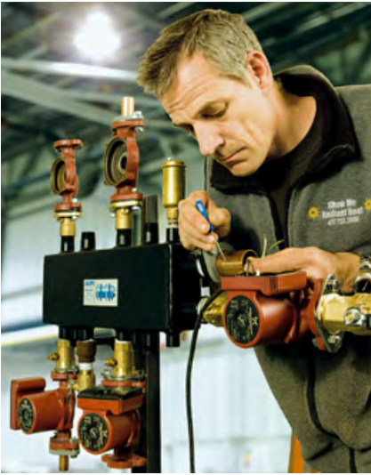
■ Монтажник компании Beib «Hot Rod» Rohr подсоединяет трехскоростные насосы к высоконапорному коллектору Caleffi HydroLink
