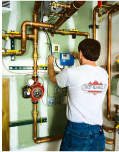
■ Монтажник компании Beib «Hot Rod» Rohr подсоединяет трехскоростные насосы к высоконапорному коллектору Caleffi HydroLink
