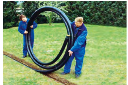
■ Укладка тепловой трубы
