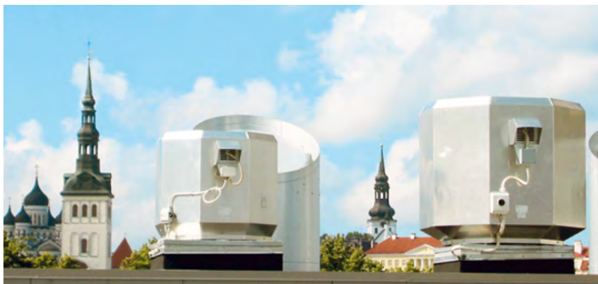
Вентиляторы DVG Systemair. Крыша жилого дома
