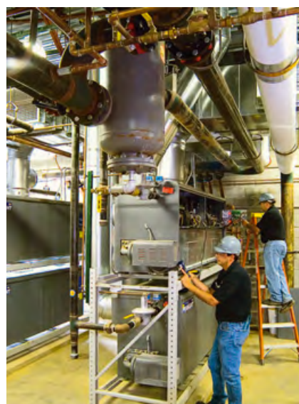
Котлы Pannant компании Laars позволяют проводить диагностику котла перед розжигом горелки
