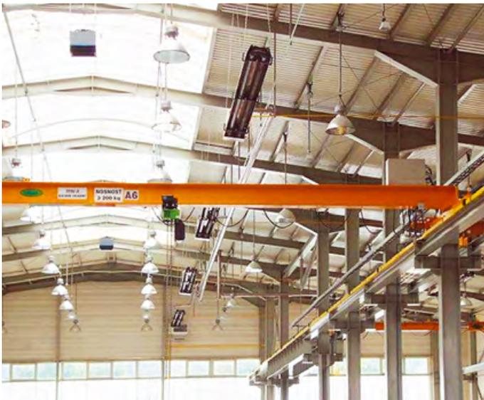
Рис. 4. Пример монтажа систем микроклимата на основе ИК-излучателей и дестратификаторов
