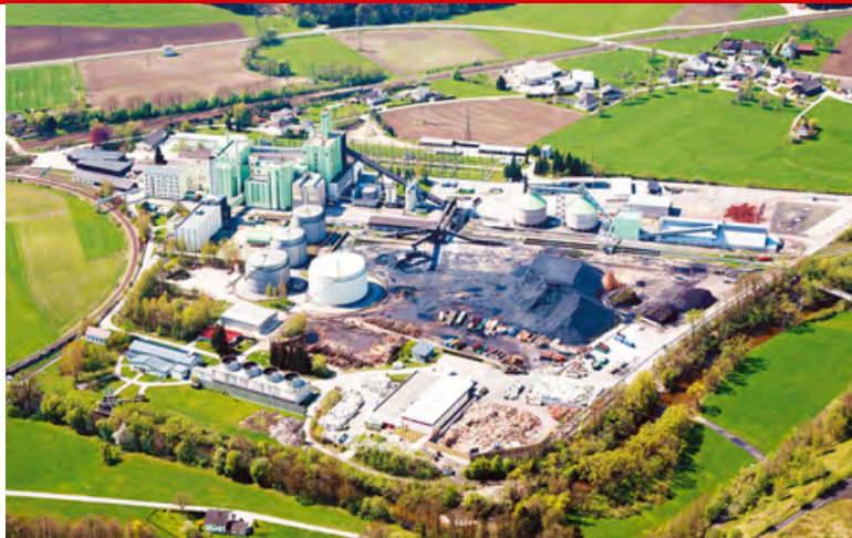
■ Рис. 4. ТЭЦ по сжиганию древесины мощностью 15 МВт тепловой и 15 МВт электрической энергии в городе Тимелькам
