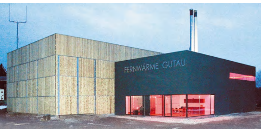
■ Рис. 1. Котельная по сжиганию древесины мощностью 2,35 МВт в поселке Гутау (Австрия)
