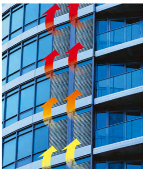
Рис.2. Потоки горячего воздуха от блоков систем кондиционирования, расположенных друг над другом.
