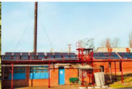
Рис. 2. Гелиоустановка котельной на хуторе Нещадимовском
