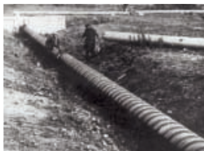
■ Рис. 1. Самокомпенсирующаяся трубная секция (1 — стальная труба; 2 — антикоррозионный слой; 3 — теплоизоляционный слой; 4 — слой механической защиты и гидроизоляции; 5 — винтовой сварной шов)
