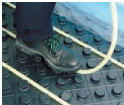
Крепление монтажных матов между собой осуществляется с помощью фальца, расположенного по краю мата. Фальцевое соединение надежно защищает стяжку от проникновения влаги. Другой вид монтажных матов NP из глубокотянутой полистирольной пленки предназначен для укладки на стандартные тепло- и звукоизоляционные панели. Маты соединяются между собой по «кнопочному» принципу накладки первого ряда бобышек на предыдущий мат.
