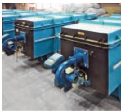
Принятая Западом концепция котлов с автоматизированными вентиляторными горелочными устройствами проще. Отпадает необходимость в установке дымоходов и регулирования разрежения в топке котла. Западные котлы приходят готовые к работе и защищенные слоем современной тепловой изоляции. Производимые у нас котлы при их установке в котельной подлежали обмуровке кирпичом или нанесением защитного покрытия слоем жаростойкой изоляции.
