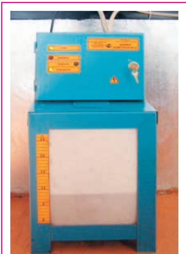
■ Рис. 8. Автоматическая система дозирования реагента «Комплексон 6»
