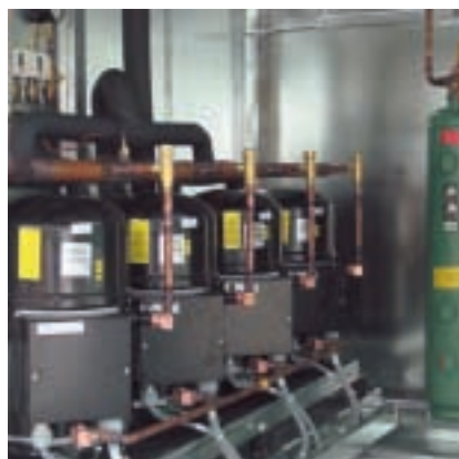
Система непосредственного охлаждения, интегрированная в центральную систему кондиционирования
