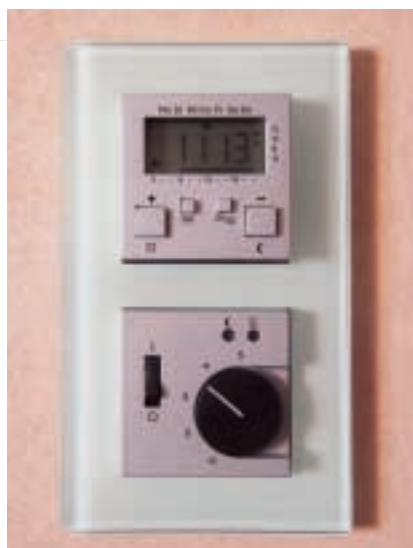
Программируемый регулятор температуры
