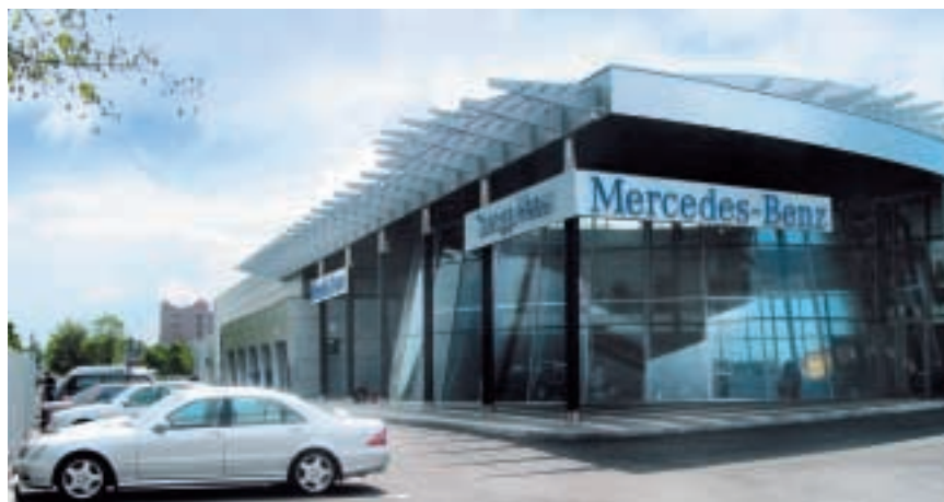
Автомобильный центр, оборудованный инженерными системами REHAU
