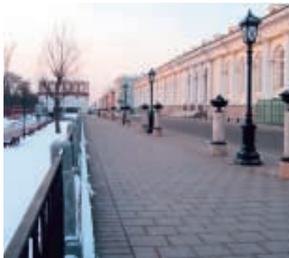
Обогрев пешеходной зоны Манежной площади в Москве при помощи систем REHAU
