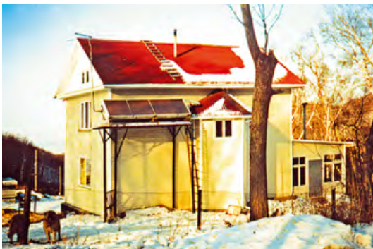
■ Рис. 4. Сезонная солнечная водонагревательная установка
