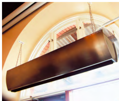
■ Завесы Portier отлично сбалансированы и могут подвешиваться на цепях в местах, где установка сложна
