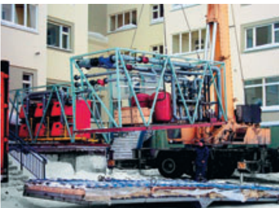
Подготовка модулей крышной котельной к подъему, г. Салехард
